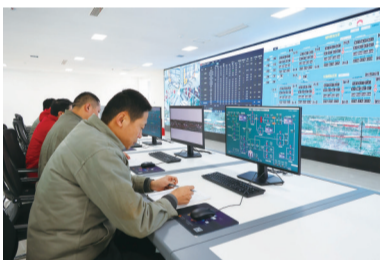
工作人员实时监控管线及站点的运行参数。
