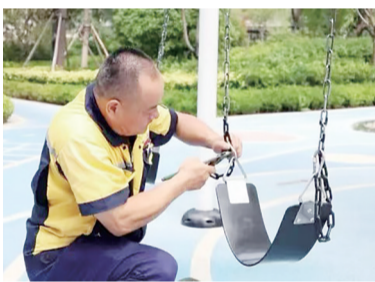
工人对小区的设施进行维修。 记者 蔡云飞 摄
