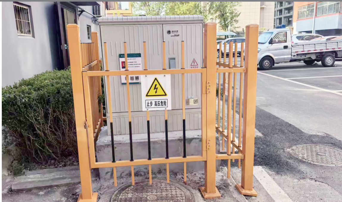
小区电力改造工程顺利完工。 通讯员供图
