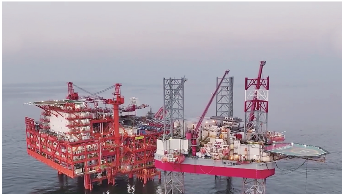
垦利10-2油田群开发项目（一期）顺利投产。（视频截图） 据央视新闻客户端
