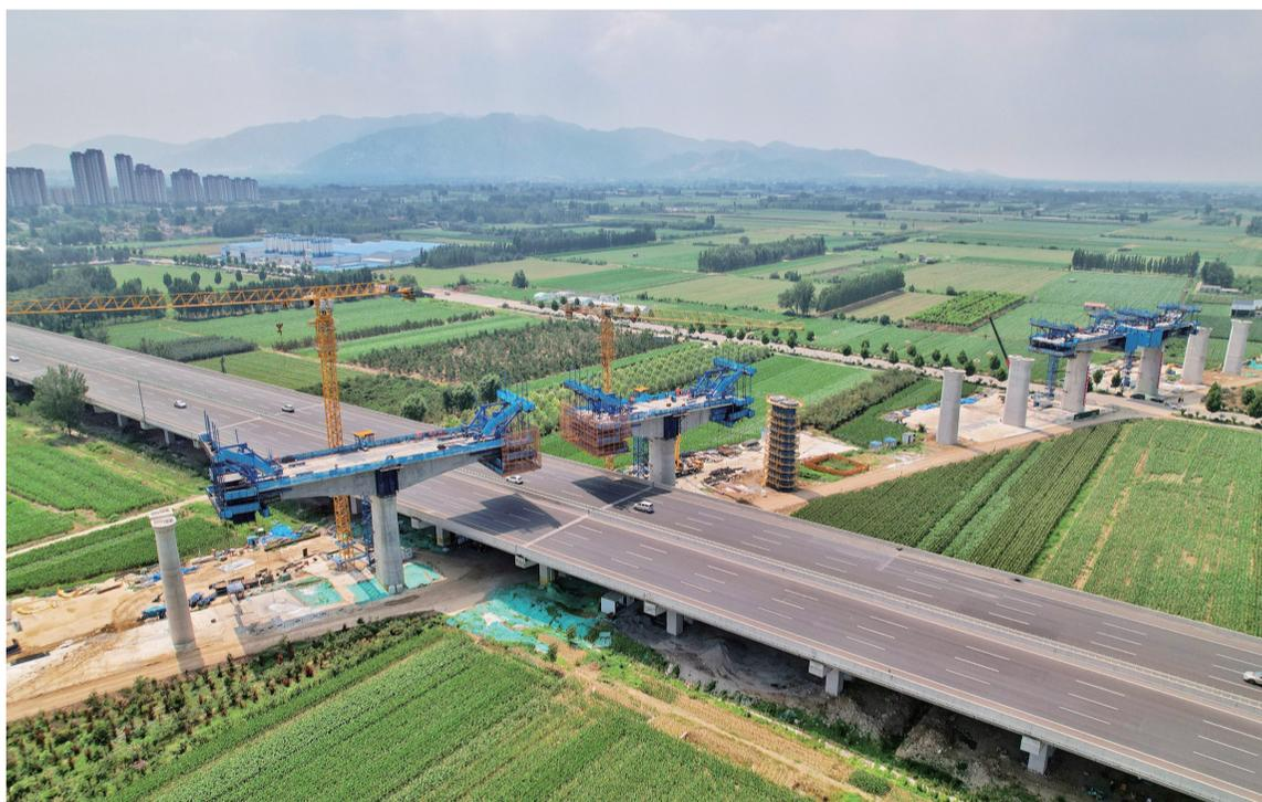
近日，在济枣高铁泰山区三标段中国建筑施工现场的鹿河特大桥上，施工机械轰鸣声此起彼伏，对一段段现浇连续桥梁进行混凝土浇筑，一派繁忙景象。其中61#至64#、67#至70#桥墩间，重达千吨的连续箱梁凌空飞架青兰高速及博城北路，济枣高铁鹿河特大桥如钢铁巨龙初现峥嵘。这条串联“一山一水一圣人”文化带的黄金旅游通道，正在泰山区23.74公里的热土上加速延伸。
