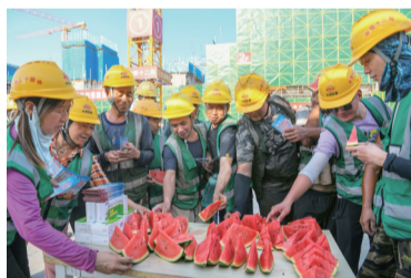
在河北雄安新区启动区西北片区小学项目建设现场，中铁十二局工人吃西瓜解暑。 资料图
