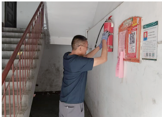
工作人员更换灭火器。 通讯员供图
