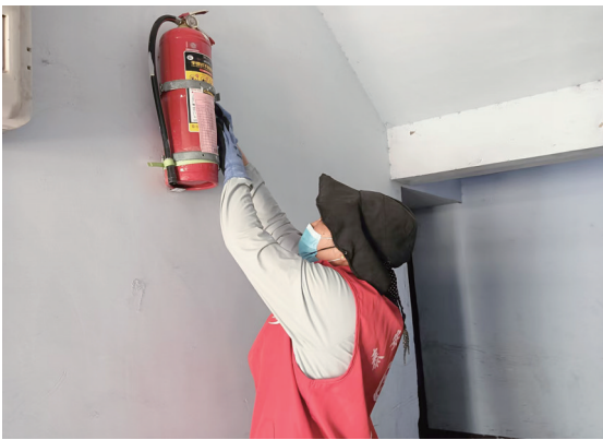
排查小组人员检查灭火器情况。 通讯员供图
