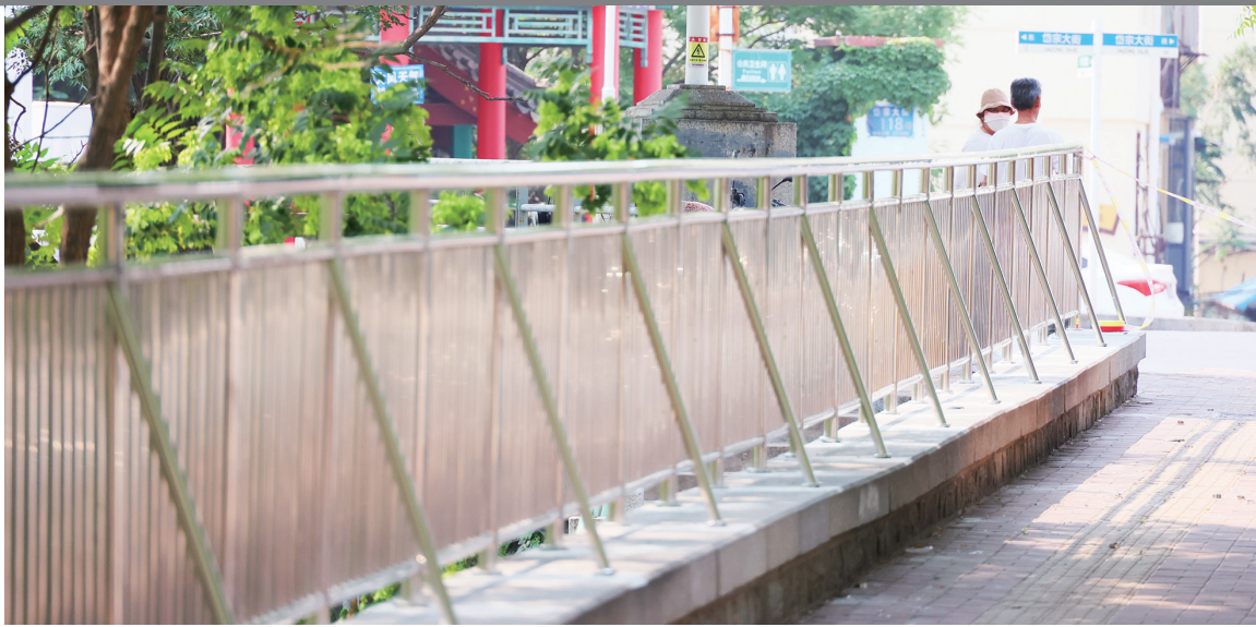
安装好的不锈钢防护栏杆。 记者 隋翔 摄
