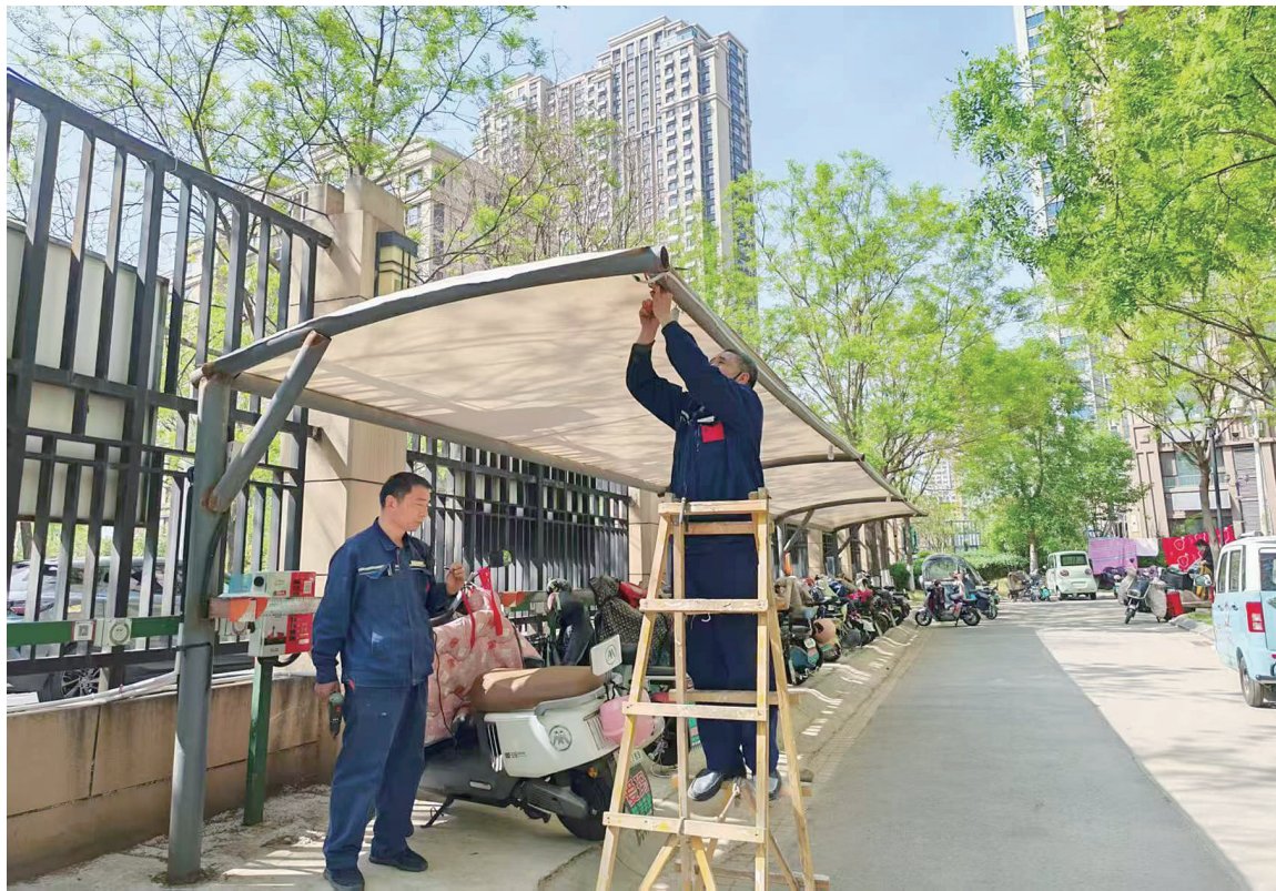
工作人员安装车棚亮化灯带。 通讯员供图
