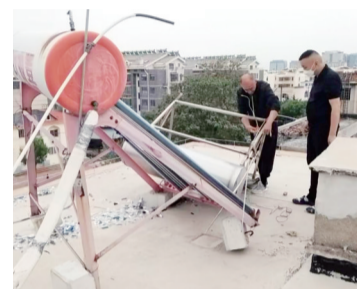
社区工作人员拆除废弃的太阳能热水器。 通讯员供图
