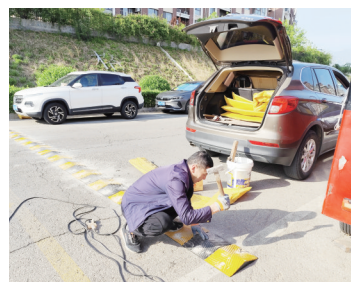
工作人员安装减速带。 通讯员供图
