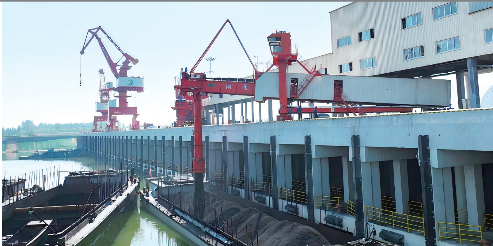
泰安港码头。 通讯员供图
