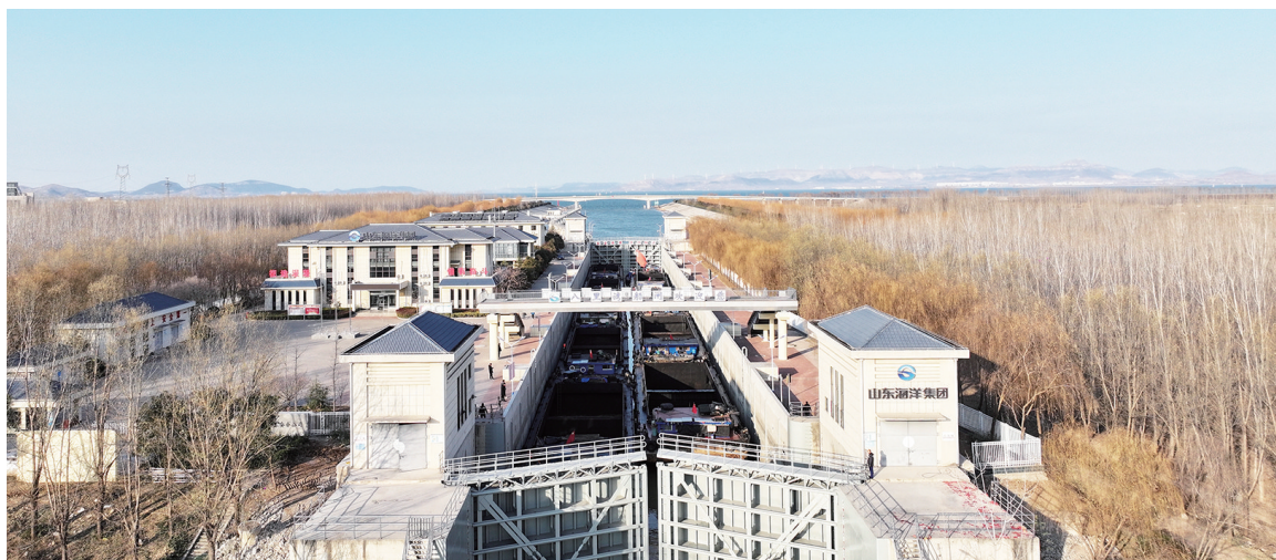
京杭运河八里湾船闸闸门缓慢关闭。 通讯员供图
