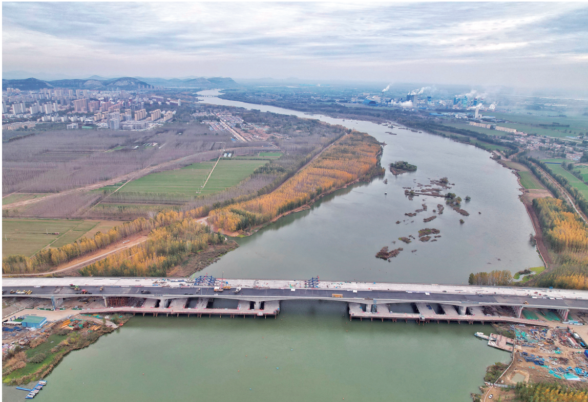
济荷高速改扩建工程施工六标段项目大清河特大桥左幅主跨顺利合龙。 记者 陈阳 摄
