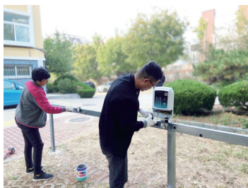
工作人员安装智能电动车充电桩。 通讯员供图
