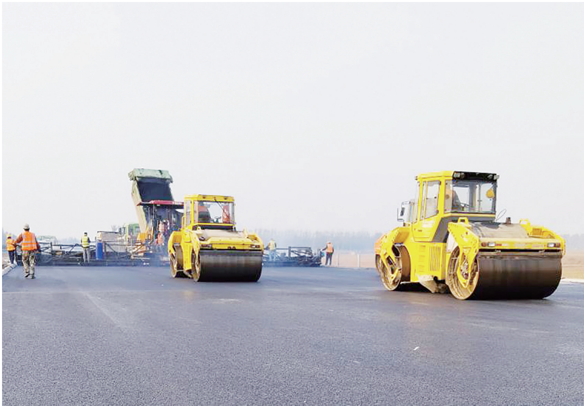
沥青摊铺现场。 通讯员供图
