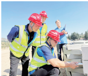
检查组现场检查工程建设情况。 通讯员供图
