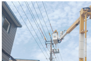
工作人员正在进行带电接火作业。 通讯员供图
