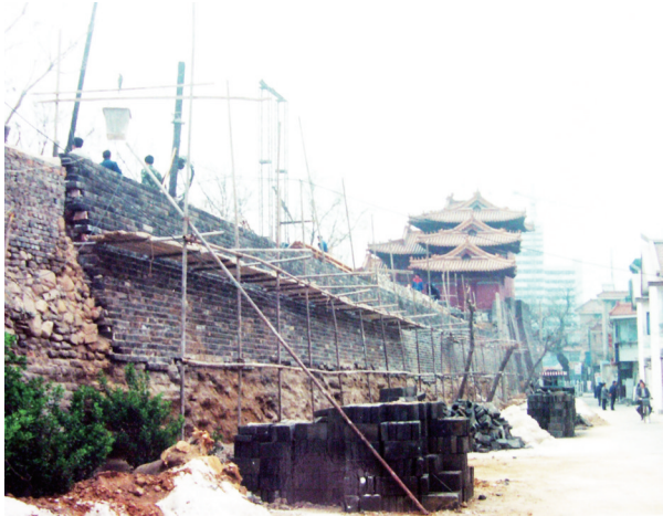
1999年，修复中的岱庙西城墙。
