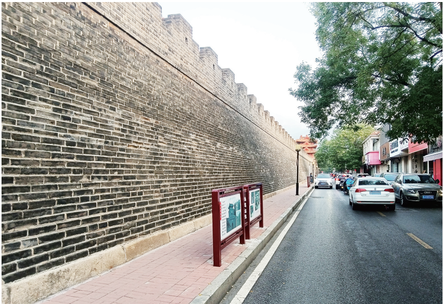
东城墙北段修复后状况。
