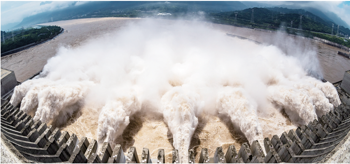
7月15日，三峡水库开启9个泄洪孔泄洪。 新华社发
