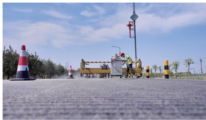
正在施工的音乐公路。 记者 蒋亮亮 摄
