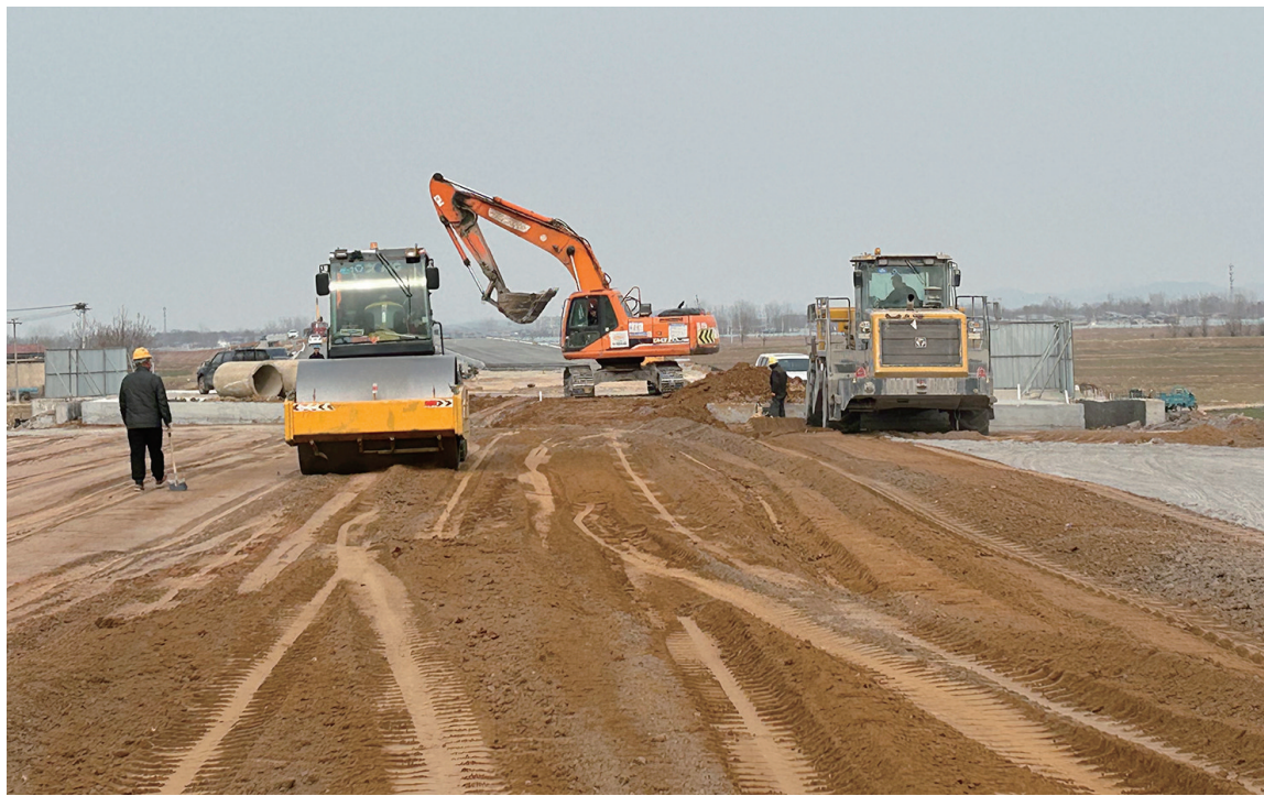
泰东高速公路项目,各项施工生产正在稳步推进。 通讯员供图
