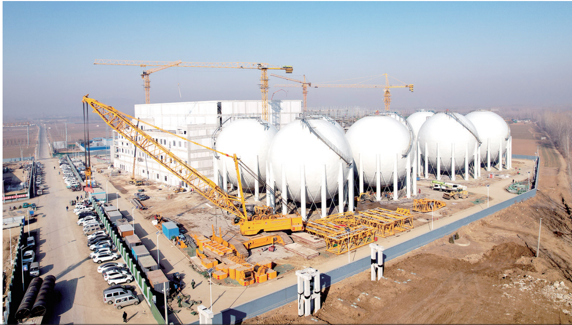
前期进行的项目阵列化蓄热装置安装。
