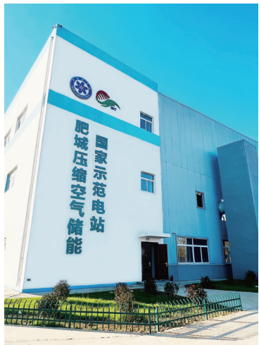
肥城压缩空气储能国家示范电站外景。
