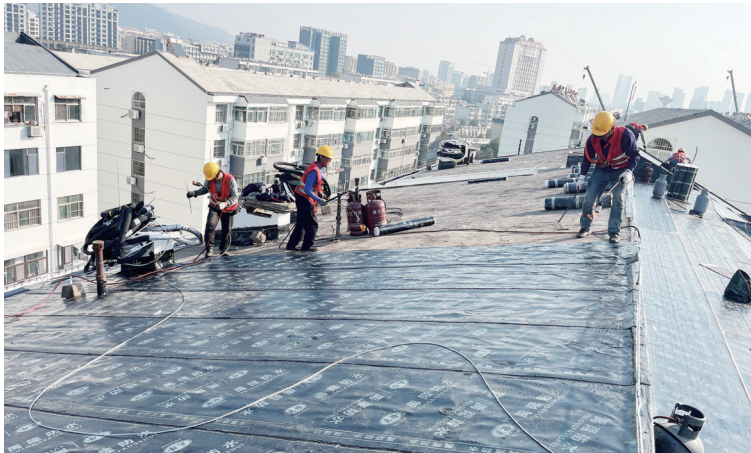
后七里社区屋顶防水施工。 最泰安全媒体记者 隋翔 摄
