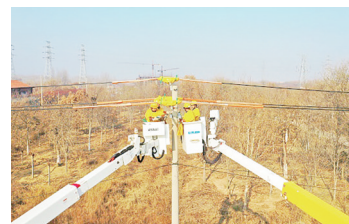
工作人员顺利完成10千伏飞鸿线07号杆带负荷直线杆改耐张杆工作。 通讯员供图
