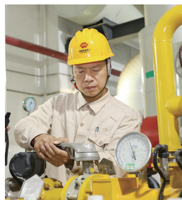
工作人员对供热首站进行检修。 通讯员供图
