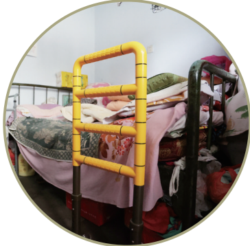
泰山区民政局帮市民进行适老化改造，在老人床侧安装扶手。
