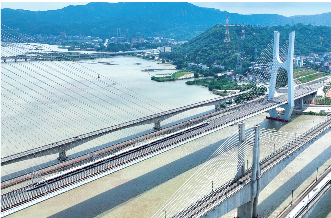
9月28日,复兴号智能动车组从福厦高铁乌龙江大桥上驶过(无人机照片)。 新华社记者 林善传 摄
