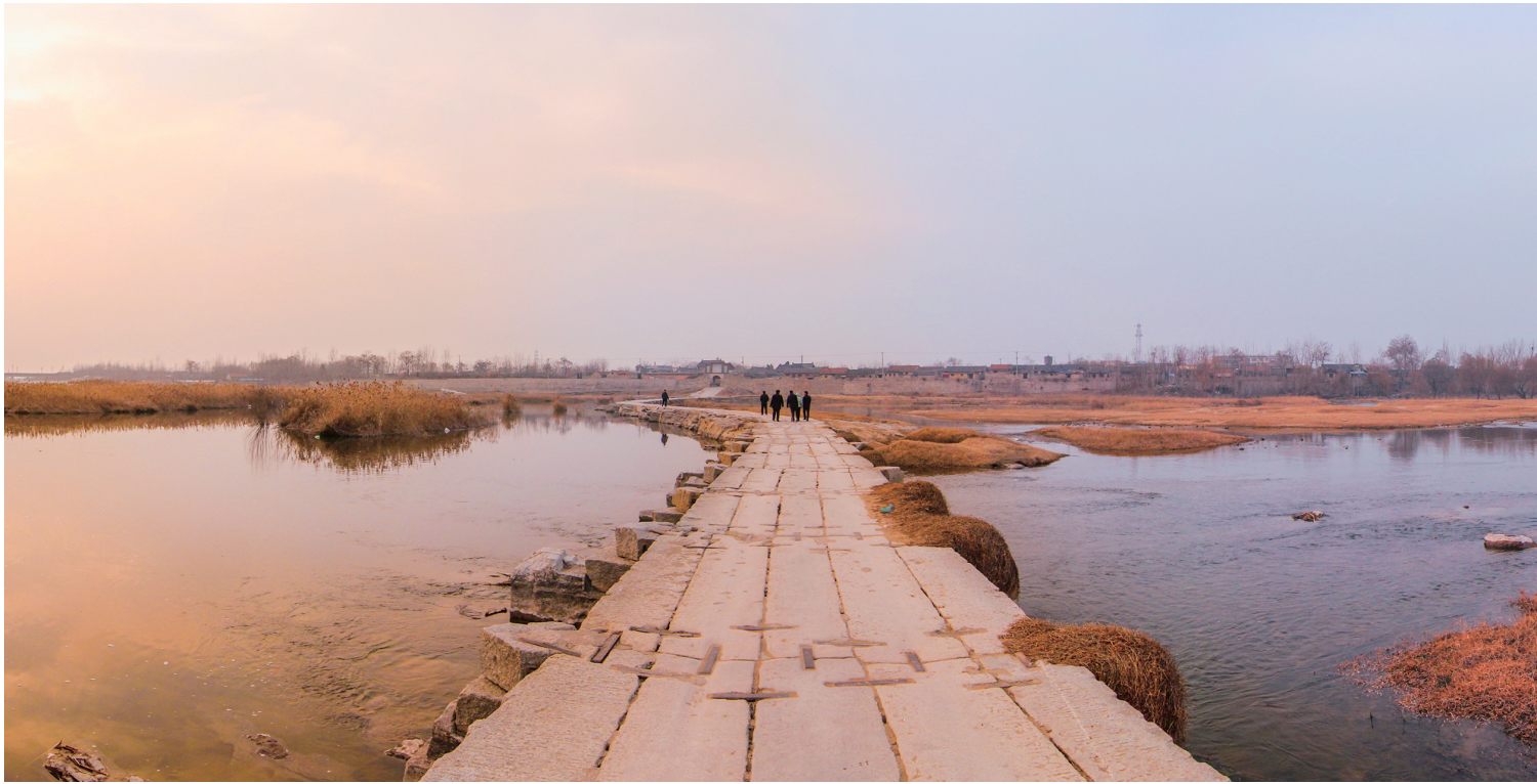
大汶口镇明石桥。 最泰安全媒体记者 隋翔 摄
