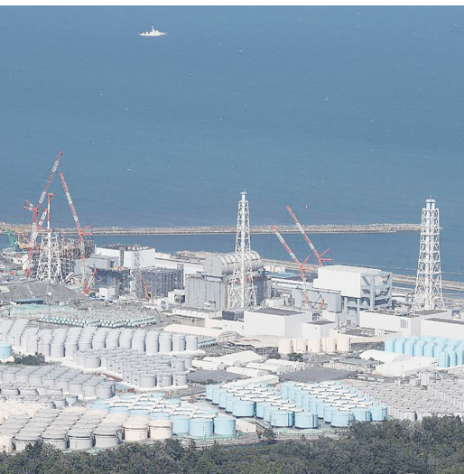
当地时间2023年8月24日，日本福岛第一核电站，存放经过处理核污染水的储罐。
