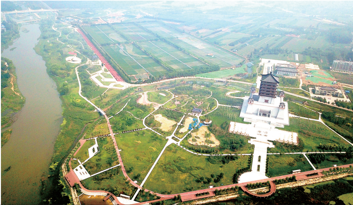
洋河人工湿地。 最泰安全媒体记者 司刚 摄
