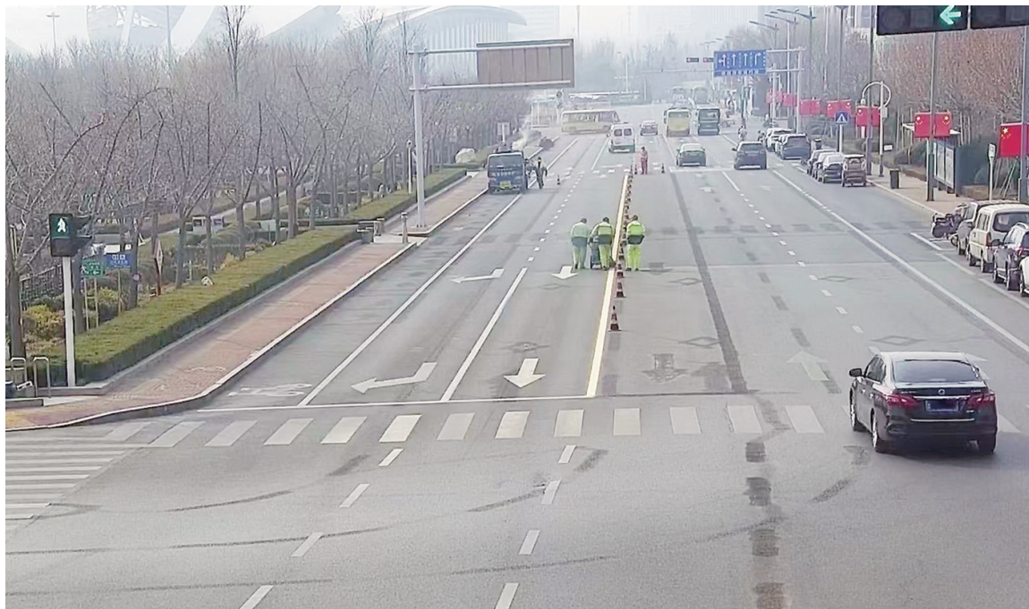
工作人员在望岳西路与府前街路口施划标线。 通讯员供图
