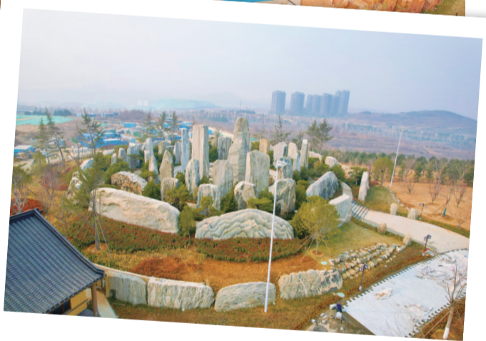
2月8日上午,在全国历史文化和民俗旅游重点项目——泰山石敢当文化园施工现场,工作人员有序施工,加紧园区建设。图为园区内的文化娱乐项目。 最泰安媒体记者 隋翔 摄
