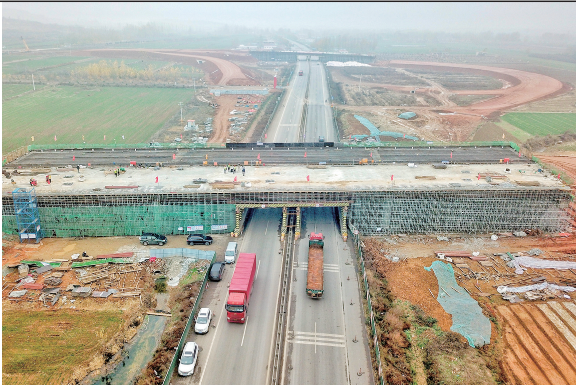
泰东高速施工现场。 最泰安全媒体记者 陈阳 摄
