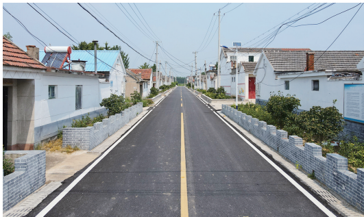
农村公路干净平整，标线清晰。
