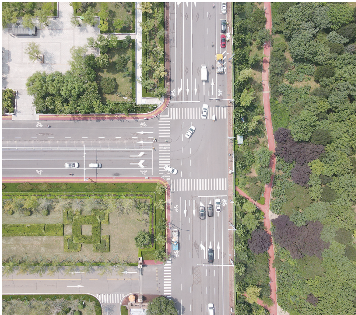
望岳西路自东岳大街至府前街路段已重新施划道路标线。 最泰安全媒体记者 隋翔 摄
