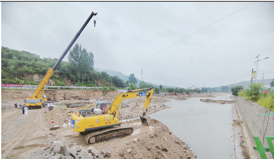
施工现场。 最泰安全媒体记者 陈阳 摄
