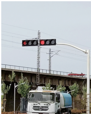
交通信号灯修理完成。
