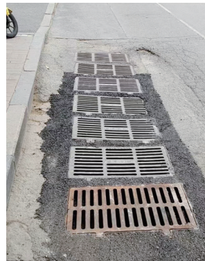
破损雨篦子修补后。
