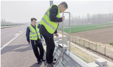
工作人员发明制作的波形梁钢护栏跨步梯。 通讯员供图
