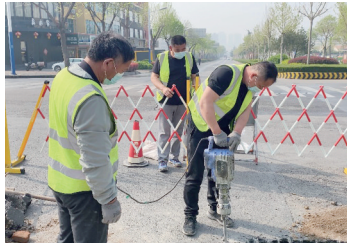
施工人员对破损、塌陷路面进行修补。 通讯员供图
