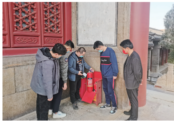
市博物馆工作人员检查岱庙内的消防设施。 通讯员供图
