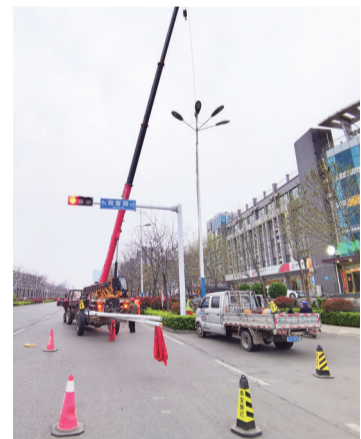
路灯所工作人员在路口补装照明设施。 通讯员供图
