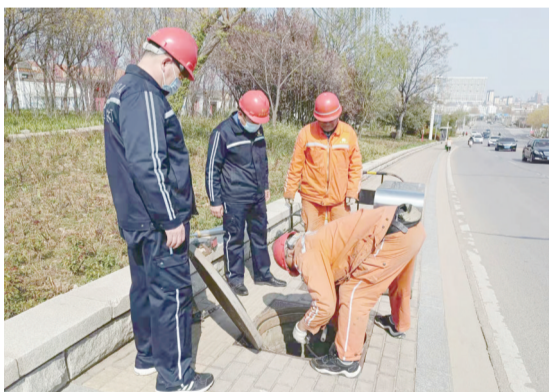
路灯所工作人员检修线路。 最泰安安全媒体记者 董文一 摄
