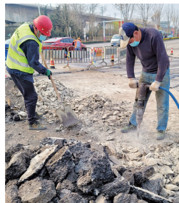
施工人员对道路进行养护。 最泰安全媒体记者 董文一 摄
