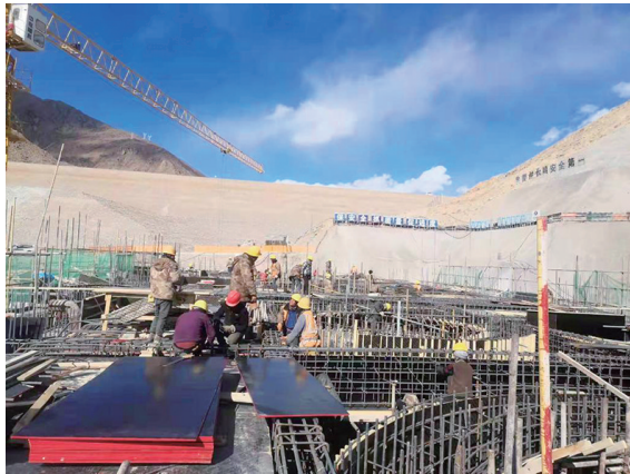
湘河水利枢纽及配套灌区工程的建设者正在安装钢筋。 新华社发
