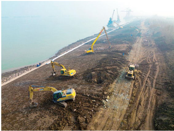
长江干流江西段崩岸应急治理工程梁公堤施工段建设现场。 新华社发
