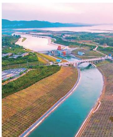
图为南水北调中线工程陶岔渠首，上游通过引水渠与丹江口水库相连，下游与南水北调中线干渠连接。
