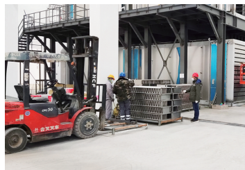
工人为项目建设抢抓时间。 最泰安全媒体记者 王玉 摄
