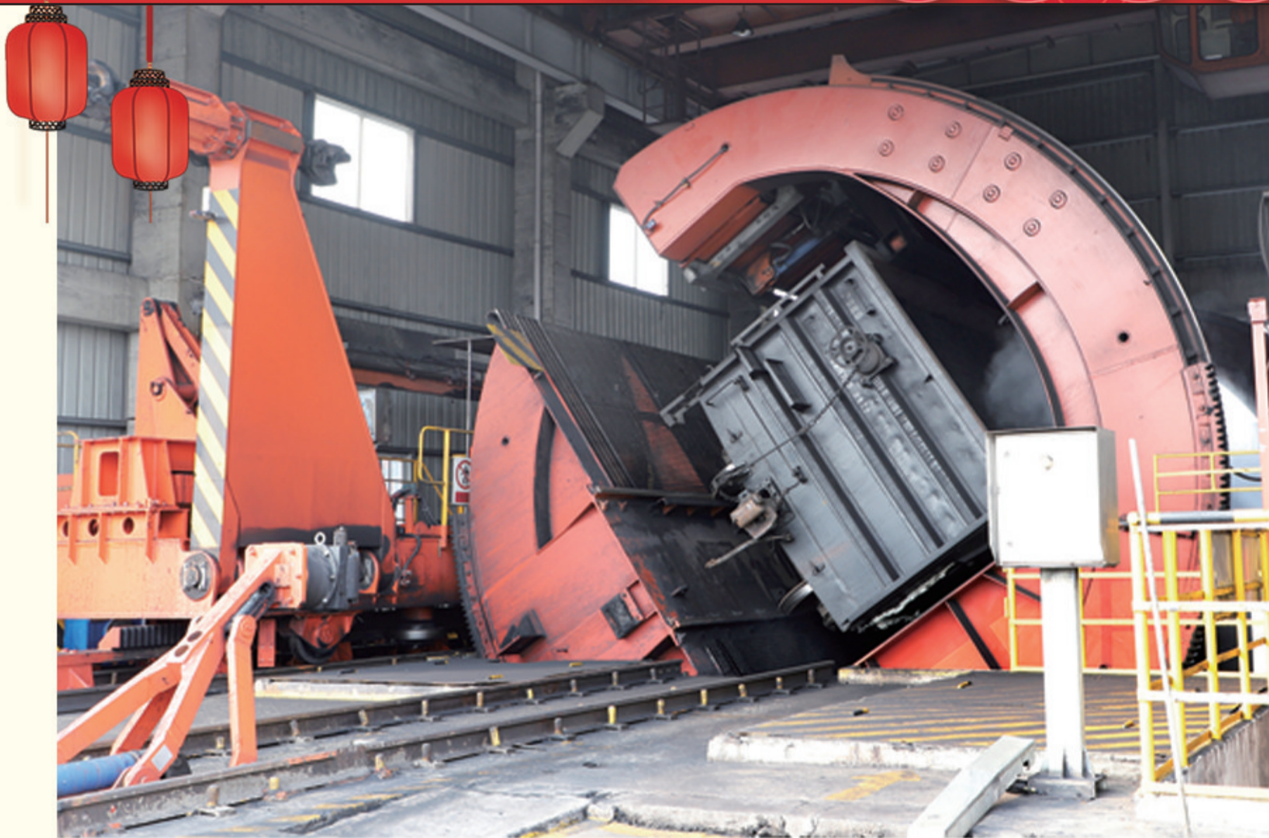
满载煤炭的车厢进入翻车机。
