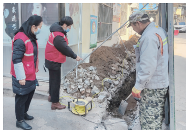
工作人员现场查看施工情况。 最泰安全媒体记者 隋翔 摄
