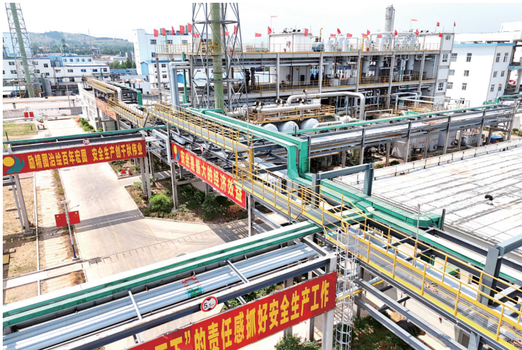
宁阳化工产业园公共廊延伸项目。
